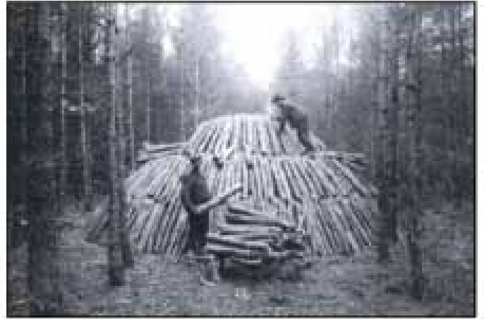
Fig.6: bouw van een houtschoolmeier
